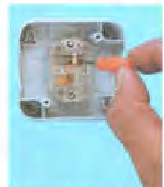
ج - برقراری اتصال پلاتین با کنتاکت غیر مشترک ۱
