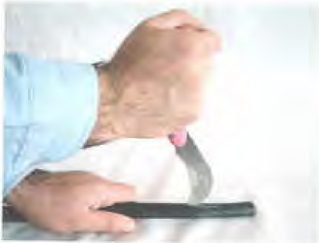
الف- نحوه‌ی غلط لخت کردن کابل
