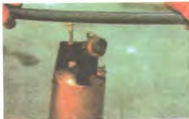
شکل ۴۳- حرارت دادن لوله‌ی PVC
