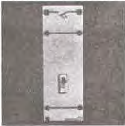
تابلوی مونتاژ شده‌ی کلید مجهز به رله‌ی حرارتی و مغناطیسی
