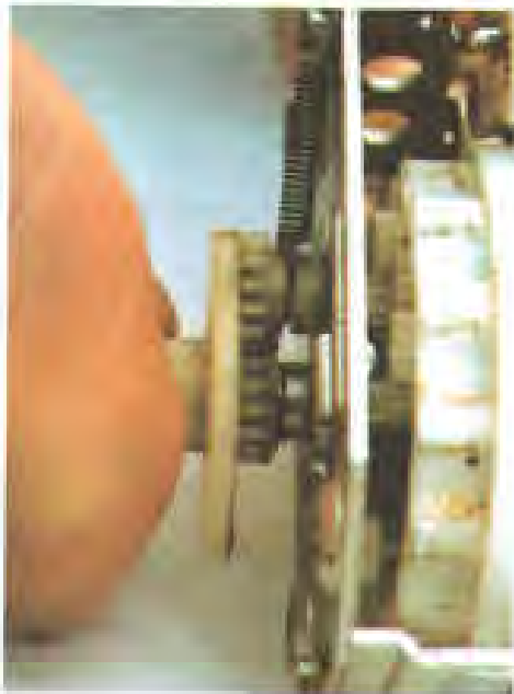
شکل ۲-۷۳ - سیم‌پیچ‌های تنظیم دقیق دستی (MFT)
