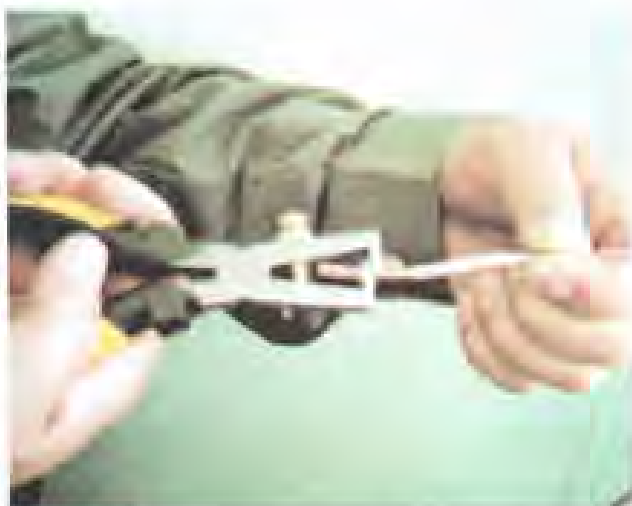
شکل ۲-۱۰- نحوه روپوش برداری از سیم های با عایق پلاستیکی
