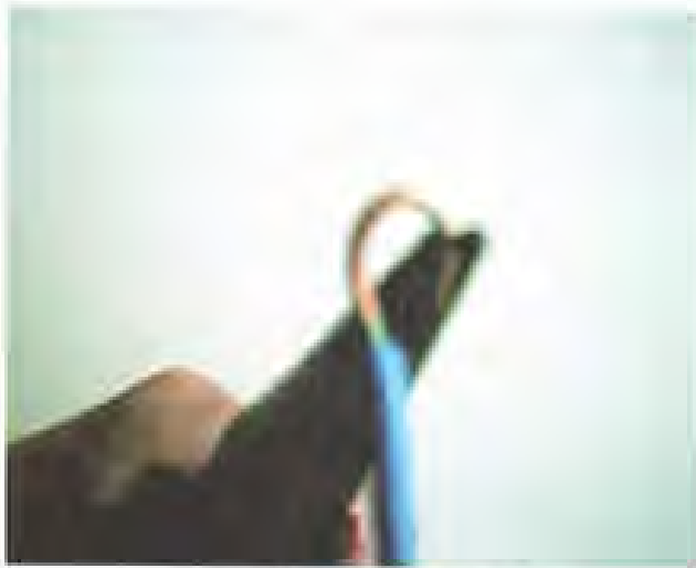
شکل ۲۳-۴ نحوه سوزنی کردن سر سیم
